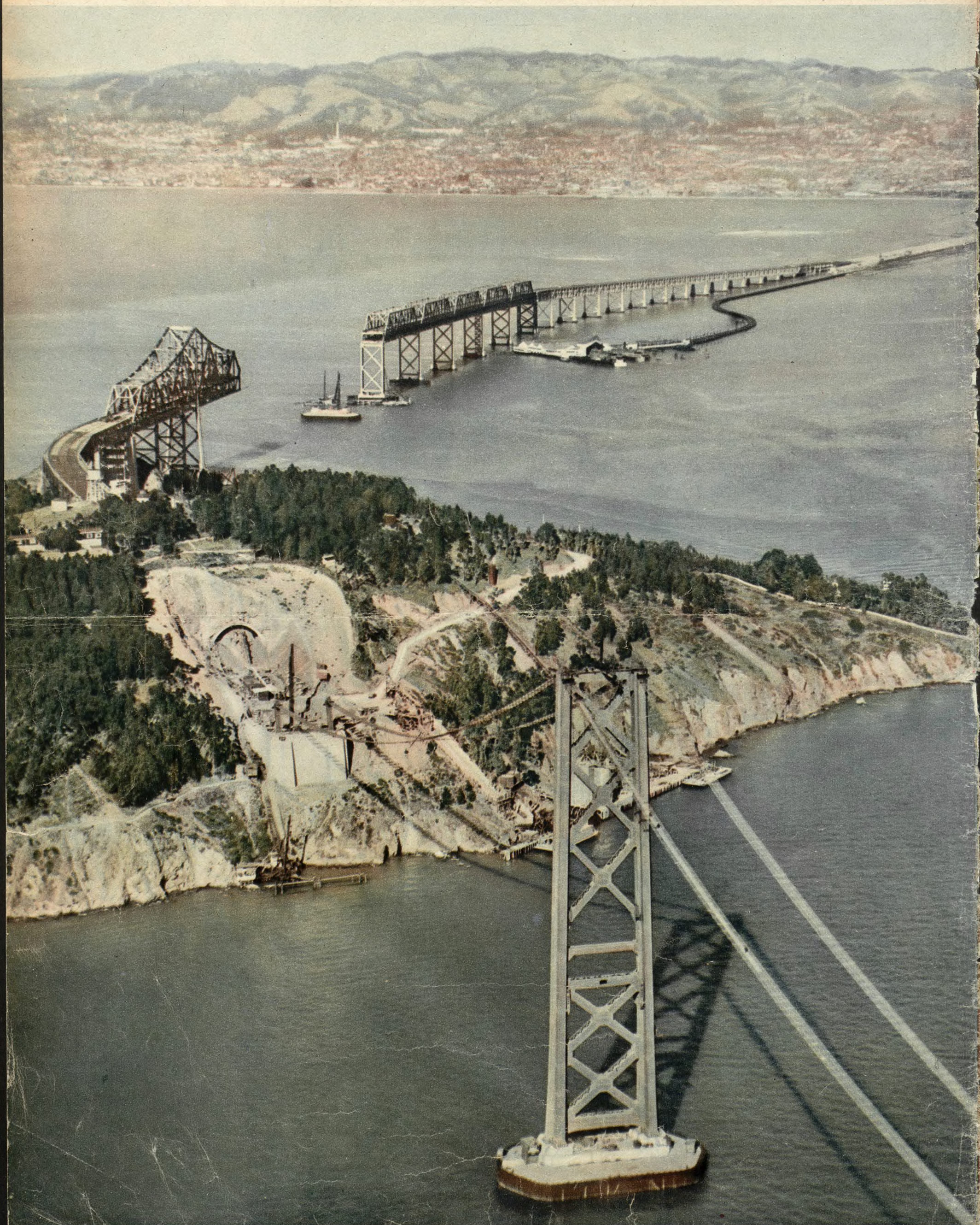
Od dłuższego czasu prowadzone są w Ameryce roboty około budowy olbrzymiego mostu, który zostanie przerzucony nad zatoką San Francisco i połączy miasto San Francisco z miastem Oakland poprzez wyspę Yerba Buena, stanowiącą rezerwat przyrody. Długość mostu wynosi ponad 7 km. Koszt budowy s
