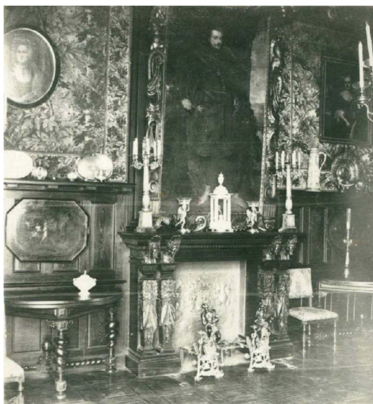
Pałac hr. Przewdzieckich przy ulicy Focal 6, jadalnia
