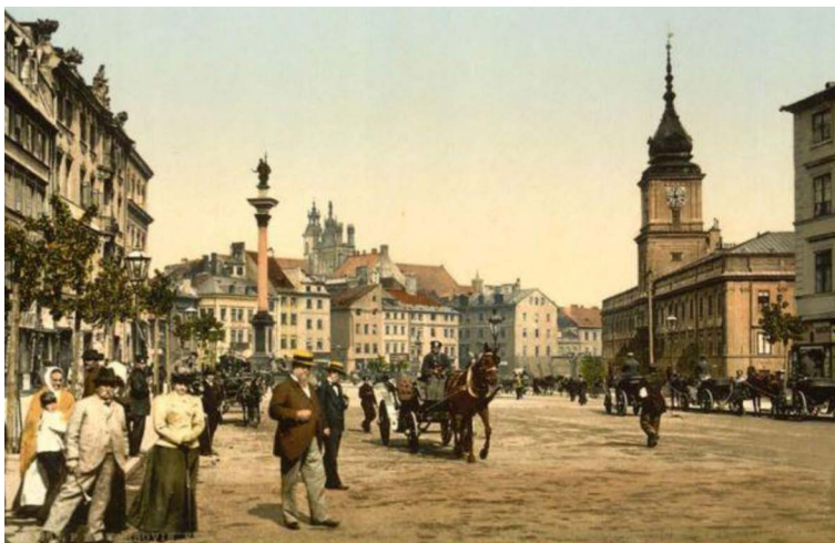
Plac Zamkowy w Warszawie pod koniec 19 wieku [fot. Library of Congress]
