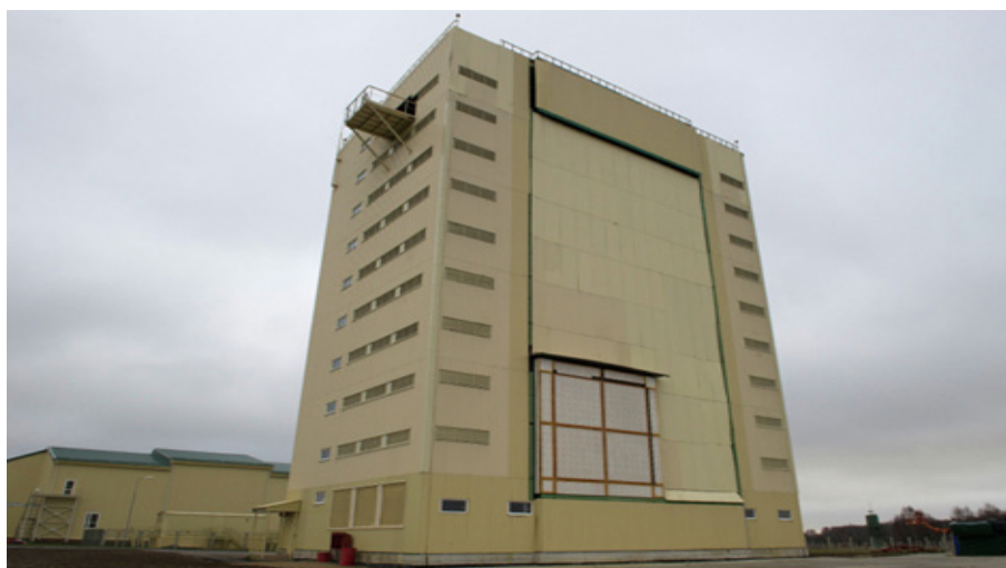
Rys. 2. Radar Woroneż-DM w Pionierskij w obwodzie Kaliningradzkim w trakcie konstrukcji. Tylko około 1/6 powierzchni antenowej obsadzona
