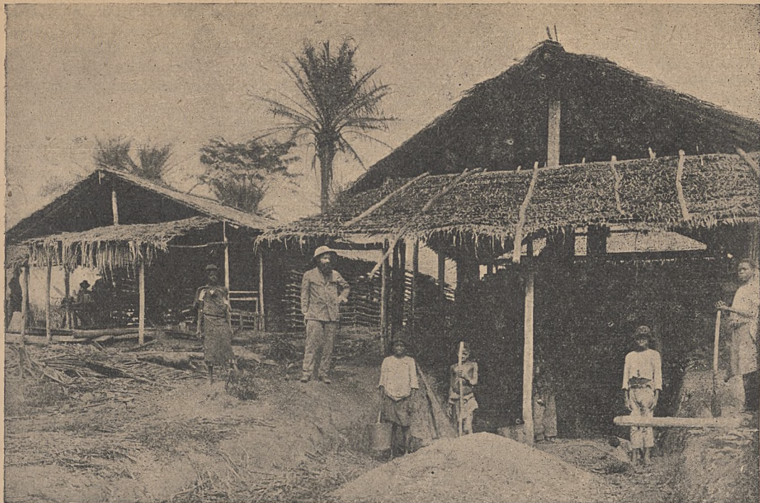
Budowa szkoły afrykańskiej
