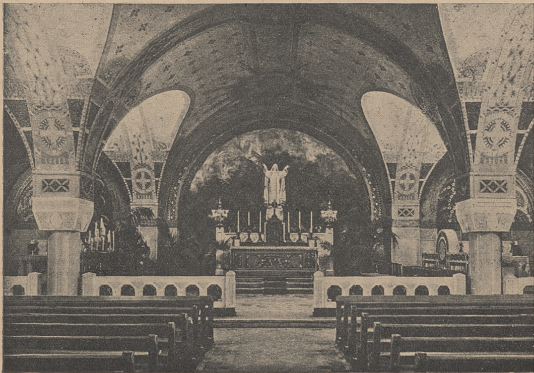
Wnętrze dolnej bazyliki św. Tereski w Lisieux
