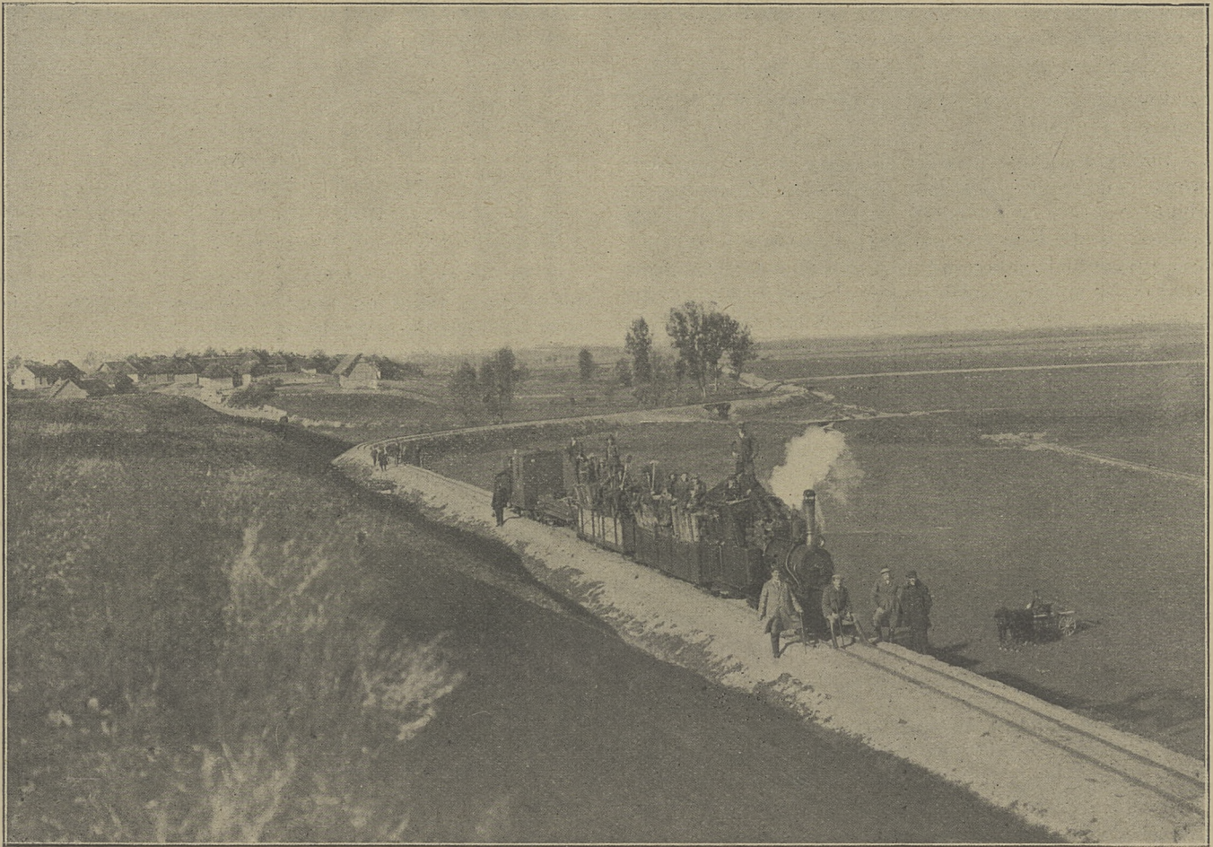
Budowa Pińczowskich Kolei Dojazdowych (układanie nawierzchni) w r. 1926.
