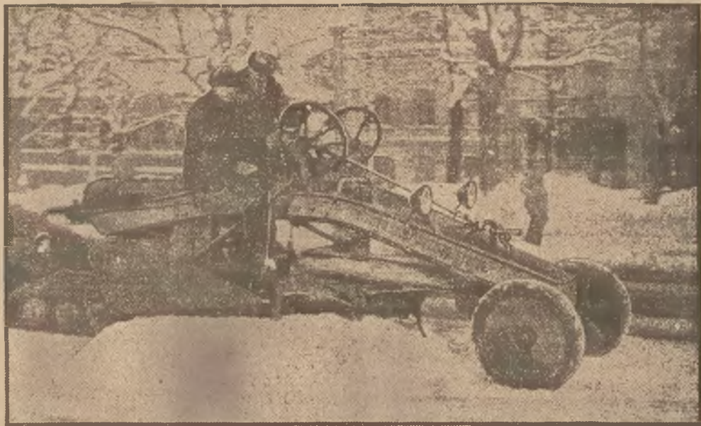
Po ostatnich opadach śnieżnych widzimy na ulicach większych miast plugi śnieżne usuwające wielkie zaspę
