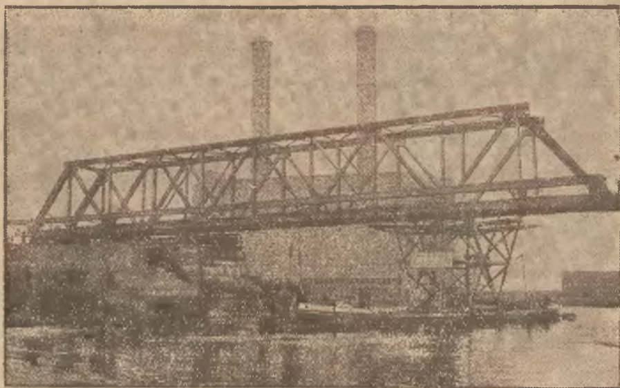
Nad Sprewą w Berlinie zbudowano w ciągu 3 godzin most, łączący dwie dzielnice. — Całą konstrukcję ustawiono na łodzi, poczem przerzucono ją tylko na drugi brzeg rzeki.
