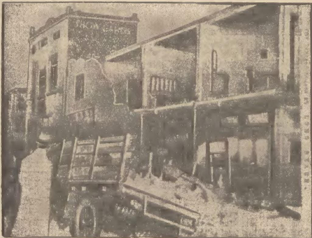
(—) Donieśliśmy przed kilku dniami o katastrofalnym trzęsieniu ziemi, które nawiedziło słoneczną Kalifornję. Na zdjęciu naszym widoczne ruiny luksusowego hotelu w wytwornym kąpielisku milionerów Long Beach w pobliżu Hollywood. Zdjęcie to przesłano drogą iskrową do Europy.
