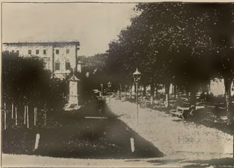
KIOSK METEOROLOGICZNY PRZY DEPTAKU.
