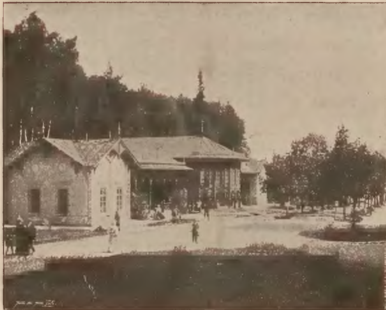
Deptak kryty ze Zdrojem głównym w Krynicy.
