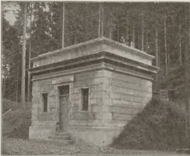
Krynica: Zbiornik wodociągu.
