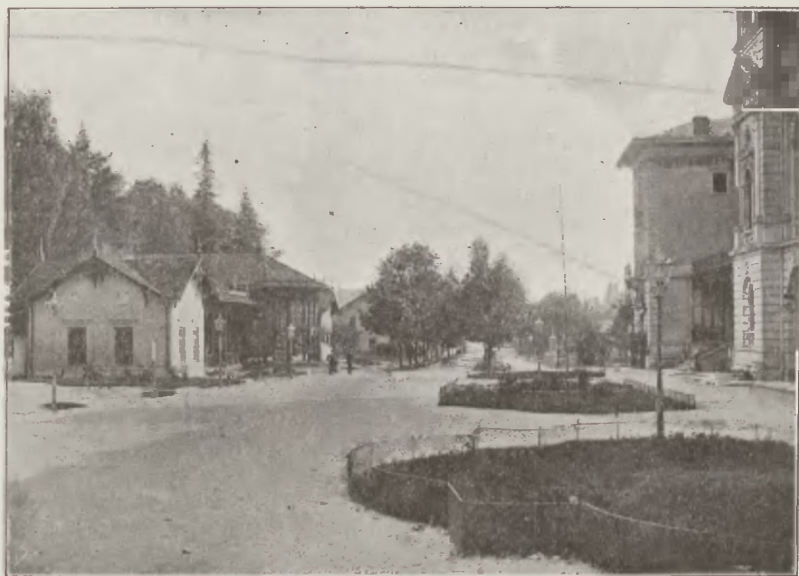
Krynica: Plac przed Domem zdrojowym i kryty deptak.
