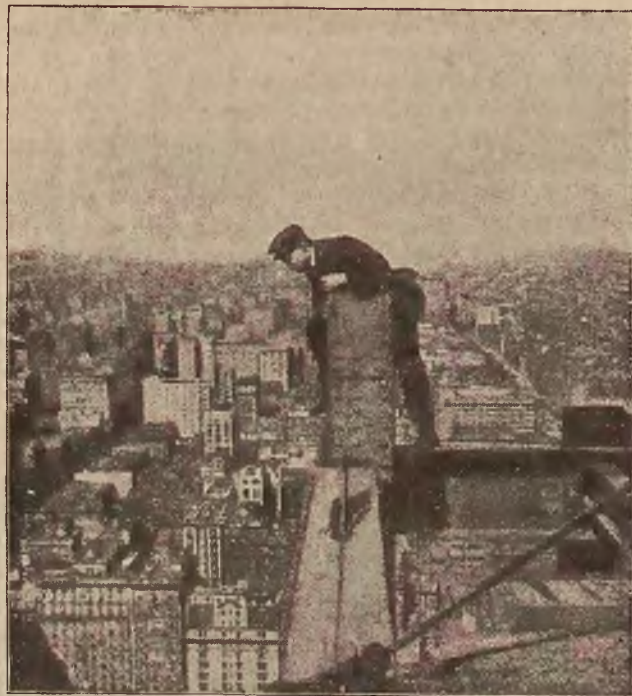
Robotnik na samym brzegu budowy na wysokości 230 metrów.
