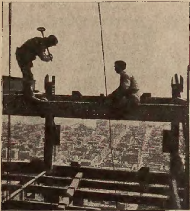
Robotnicy między niebem a ziemią na 35 piętrze.
