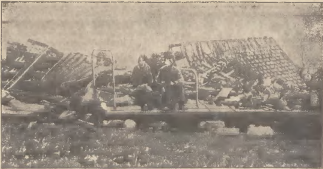
Na zdjęciu ruiny domostw w Tennessee (Stany Zjednoczone), gdzie, jak donieśliśmy szalał straszliwy tornado, wyrządza jąc olbrzymie szkody.
