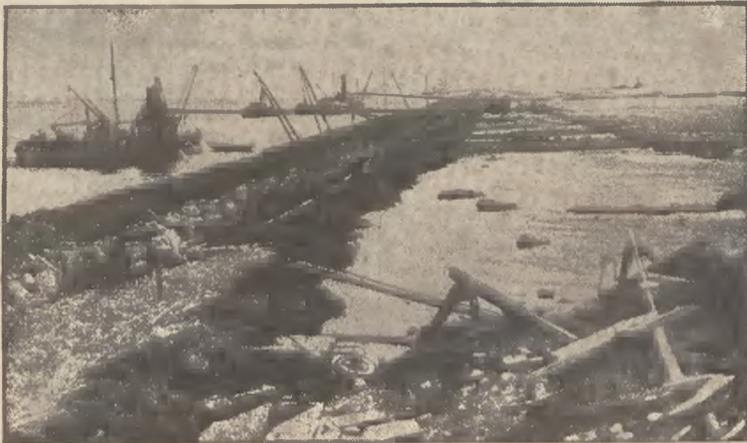
Jak już donieśliśmy, dodano ostatnio zamknięcia tamy, oddzielającej Zuydersee od Morza Północnego. Na zdjęciu widok tamy.
