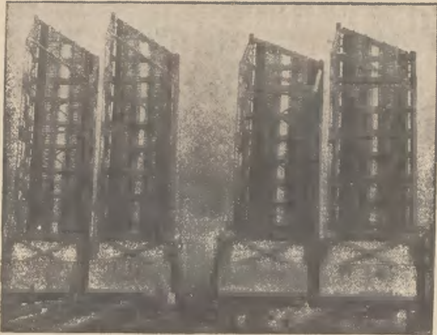
Podczas budowy olbrzymiego mostu w Bostonie zamontowano jego najgłówniejsze części w fabryce i przewożono go na kółkach na miejsce przeznaczenia. Na zdjęciu widzimy właśnie transport mostu.
