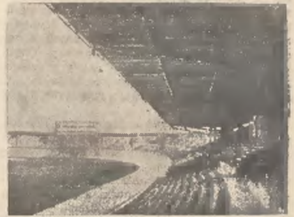
Stadion olimpijski w Amsterdamie zbudowany na szkielecie stalowym
