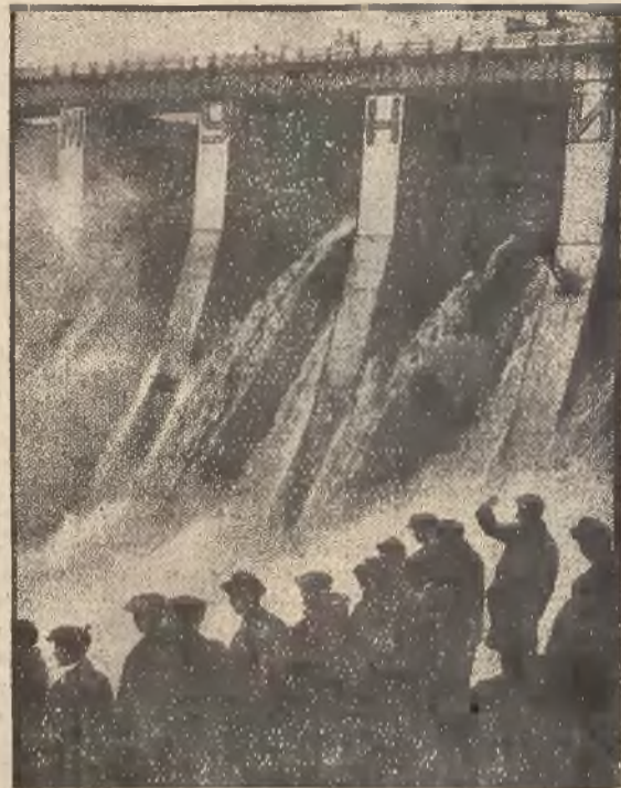
W Rosji została oddana do użytku olbrzymia tama na Dnieprze, która jest połączona z zakładami elektryfikacyjnymi. Będzie ona dostarczała prądu o sile 720.000 HP. obszarowi 82.000 km. kw.
