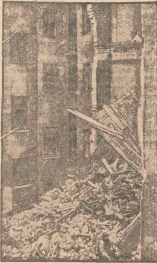
Widok zburzonej oficyny przy ul. Freta 16.
