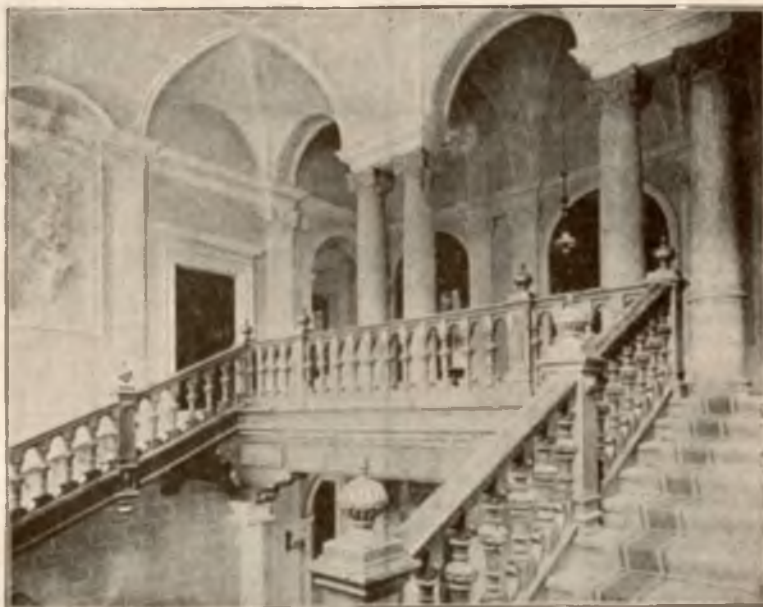
KLATKA SCHODOWA W DOMU ZDROJOWYM.
