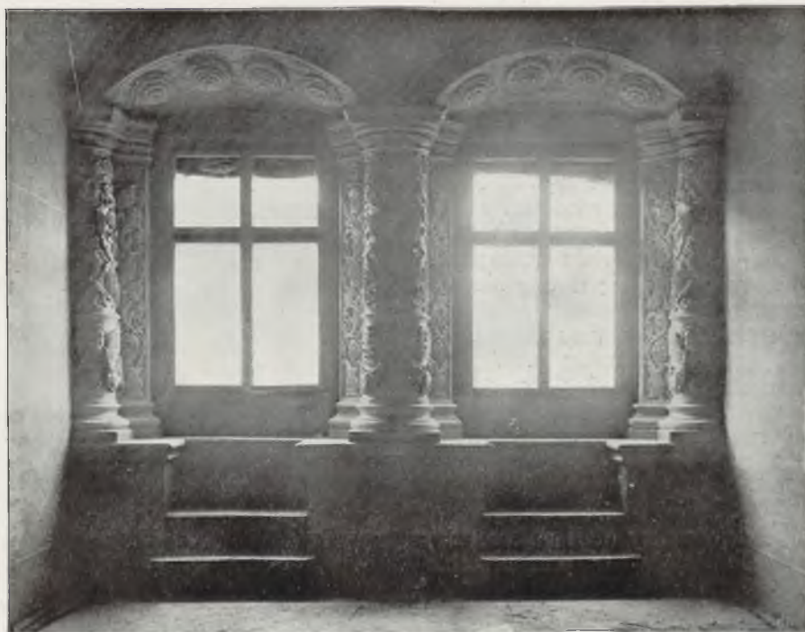
OKNA RZEŻBIONE W KOMNACIE I-go PIĘTRA.
