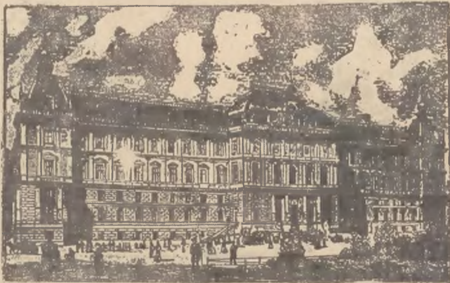
Wiedeński pałac sprawiedliwości padł pastwą płomieni po uprzednim zdemolowaniu go przez demonstrantów.
