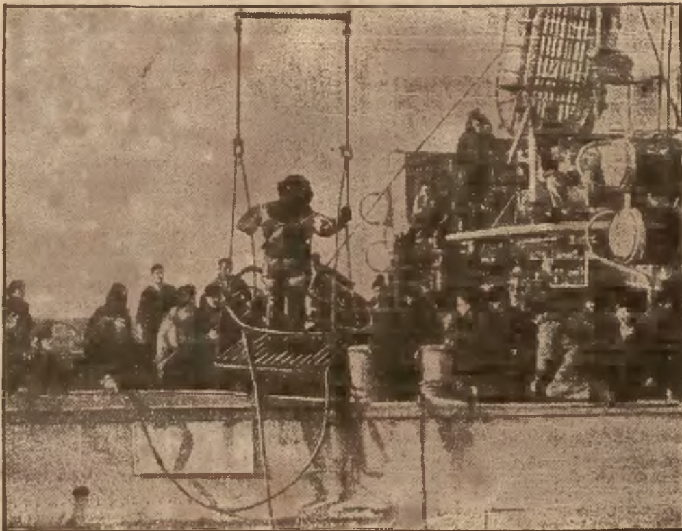
Ilustracja nasza przedstawia pierwsze autentyczne fotograficzne zdjęcie prac około ratowania zatoniętej amerykańskiej łodzi podwodnej. Właśnie wyciągają z wody jednego z nurków, którzy porozumiewali się z żyjącą jeszcze wówczas resztą załogi.
