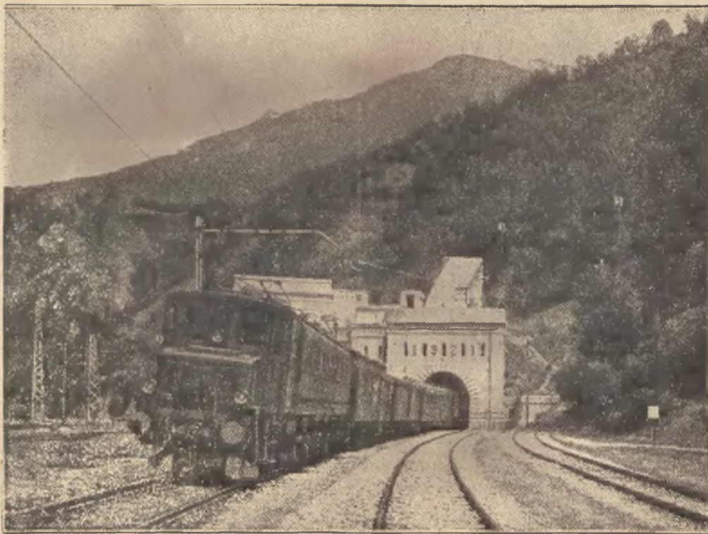
Przed 30 laty, 2 kwietnia 1905 r., odbyło się uroczyste otwarcie tunelu simplońskiego, przez który prowadzi bezpośrednia komunikacja pom. Francją a Włochami. Budowa tego tunelu, przeprowadzona w niezwykle ciężkich warunkach, trwała przez 7 lat. Po wojnie przebito drugą sztolnię tak, że tunel simploński jest dwutorowy. Nasza ilustracja przedstawia północne wejście do tunelu.
