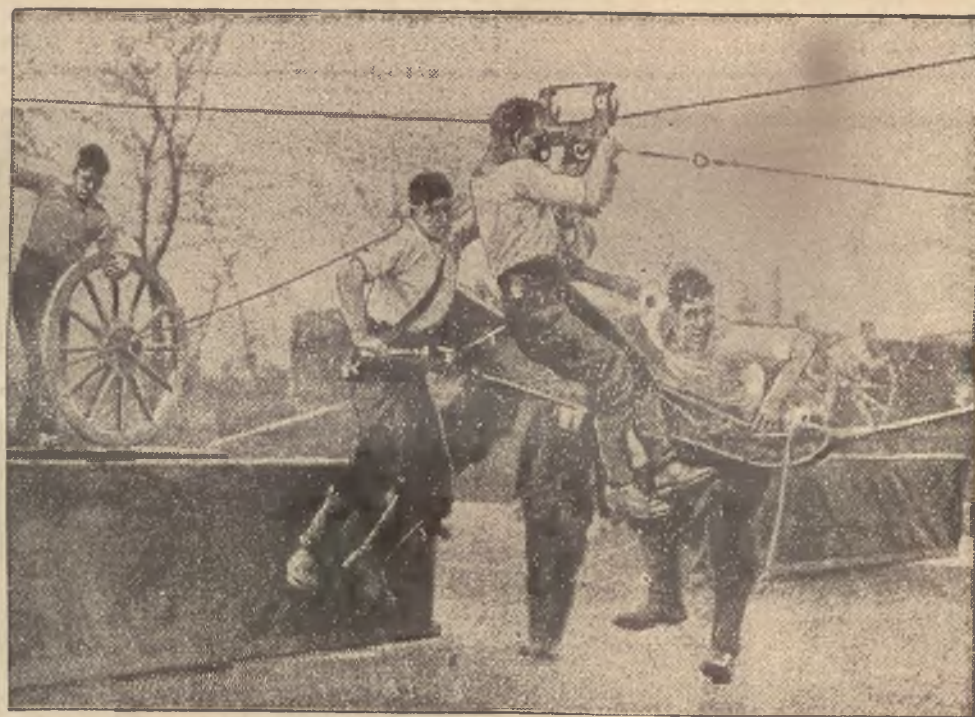
Widzimy tutaj ciekawe ćwiczenia angielskiej artylerji polowej. Rozebrane działo wraz z łożą transportuje się przy pomocy kolejki linowej.
