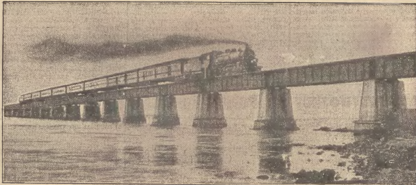
Jedną z najpotężniejszych linii na świecie jest linia, łącząca Key-West z Miami na Florydzie. Na przestrzeni 120 km prowadzi ona nad oceanem. Na odcinku tym znajduje się przeszło 100 mostów, rzuconych ponad koralowymi rafami.
