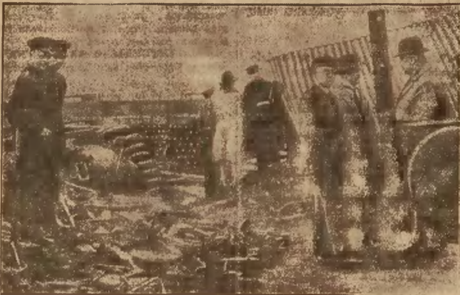
Ilustracja nasza przedstawia miejsce strasznej katastrofy spowodowanej pęknięciem tanku z fosgenem w Hamburgu. Na prawo z boku widać zerwany przez eksplozję gazu dach blaszany pobliskiego domu
