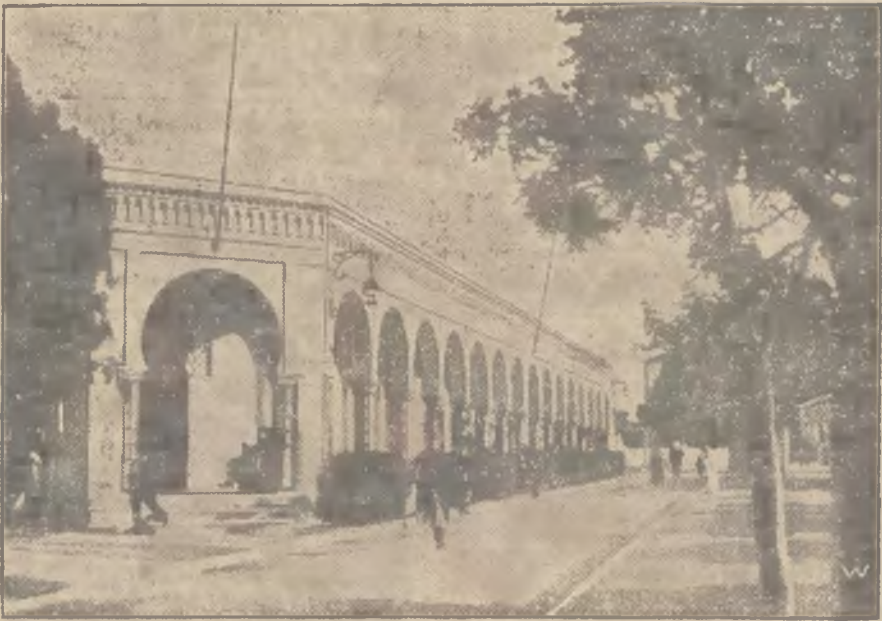
Rycina nasza przedstawia budynek konsulatu francuskiego w Uzdźda, gdzie toczą się przedwstępne
