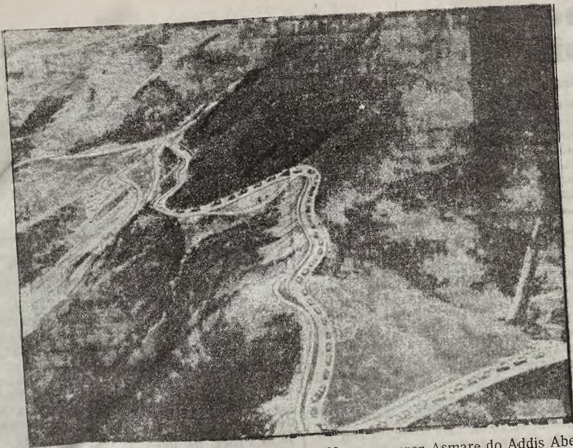
Powyższe zdjęcie dokonane z samolotu, przedstawia nam nowowyprowadzoną autostradę, łączącą miasta abisyńskie. Autostrada ta ciągnie się od por-
