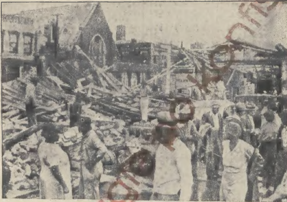
Oto ruiny, jakie pozostawił po sobie huragan, jaki przeszedł nad miastem Charleston w Ameryce. Pod gruzami zwalonych domów zginęło dwadzieścia sześć osób.
