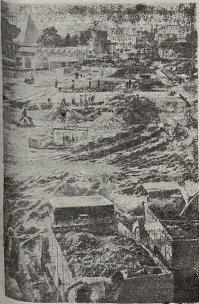
Prace przygotowawcze dla przyjęcia Hitlera w Rzymie są w pełnym toku. Tu widzimy budowę nowej alei triumfalnej, która nosić będzie nazwę „Adolf Hitlerstr.“
