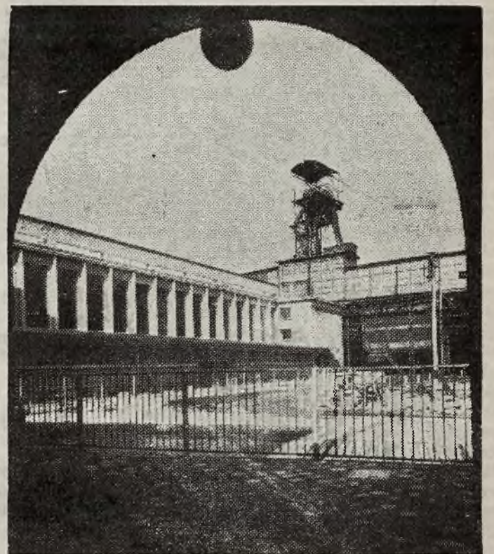
Nowoczesna kopalnia „Wanda - Lech“.
