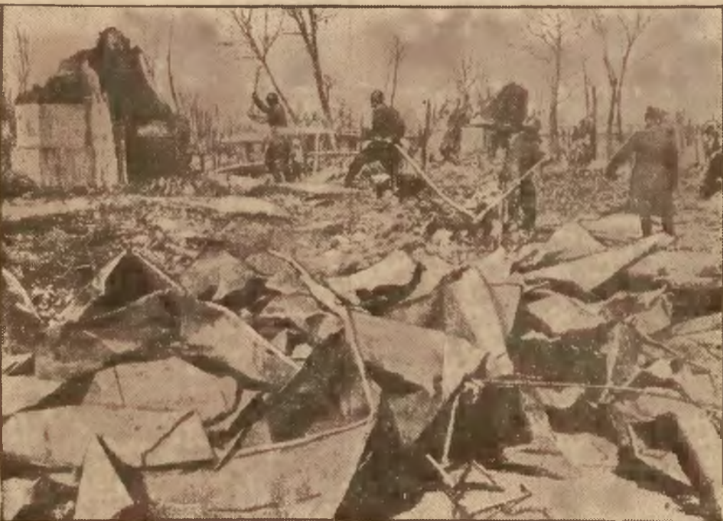
Zaluszczona przez pożar wieś Boltu w Rumuni. Pastwą ognia padło 300 zagrod chłopich
