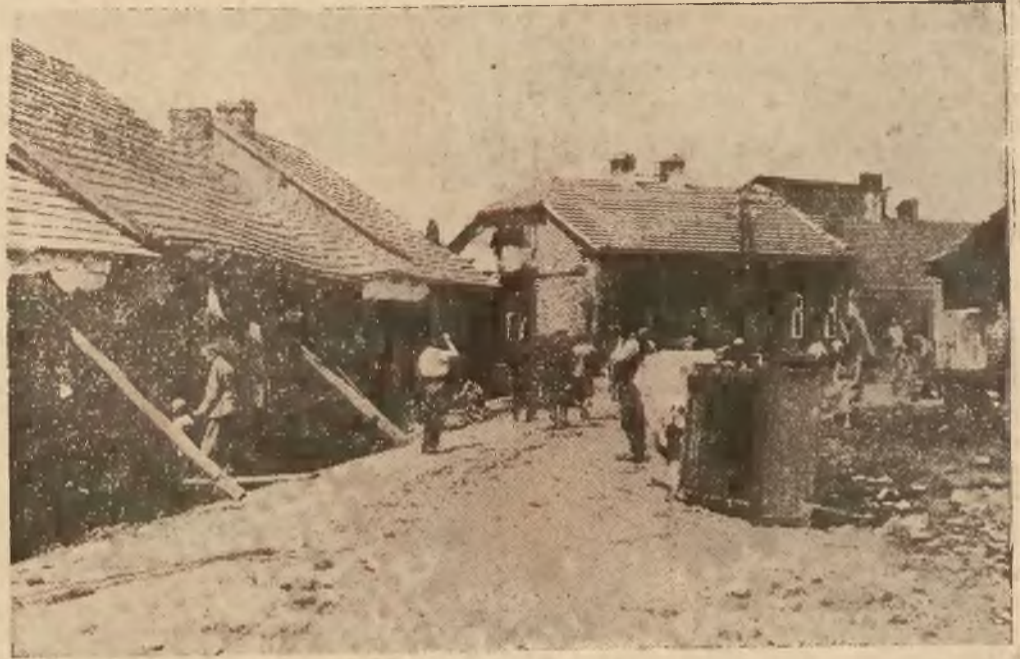
Jedna z ulic w Działoszycach, która zalana była wodą po same dachy domów, w których powrywane były całe ściany.
