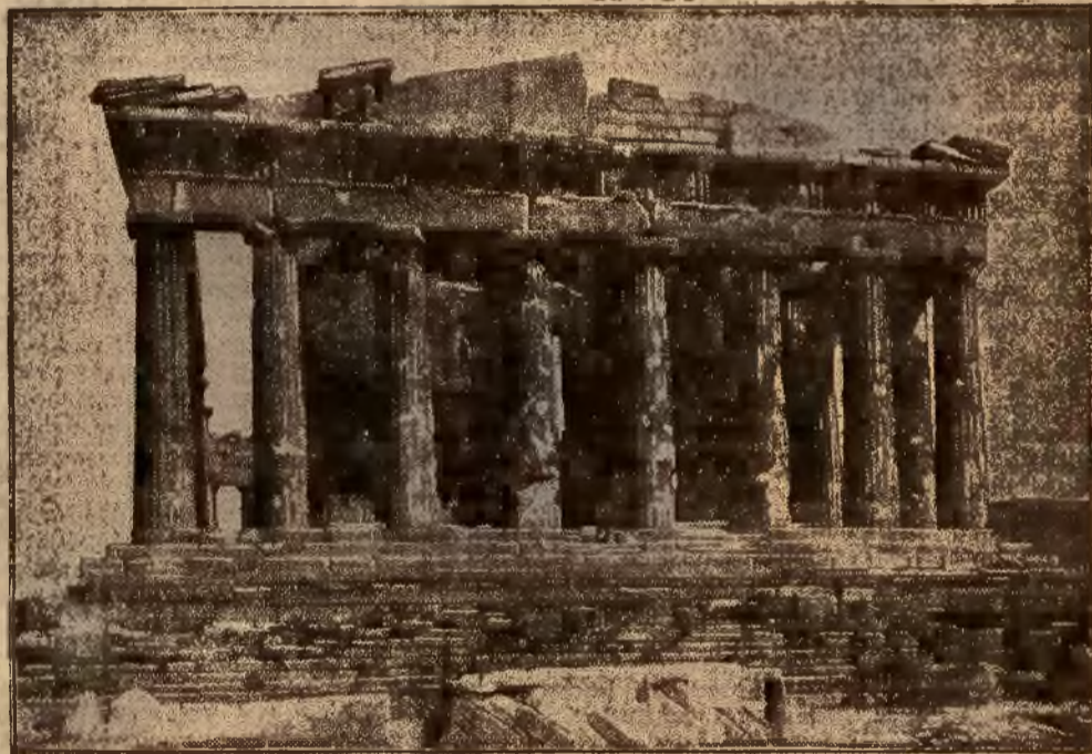
PARTENON NA AKROPOLIS ATENSKIM uległ wskutek niezwykle ostrych mrozów poważnemu zniszczeniu. Władze greckie w porozumieniu z archeologami i architektami przedsięwzięły środki zaradcze dla zapobieżenia dalszemu zniszczeniu cennego zabytku.
