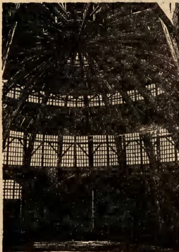
WNĘTRZE DANCINGU. Projekt inż. arch. J. Müllera. Konstrukcja: pełne wieżary łukowe z desek; rozpiętość wolna 30 m., wysokość 18 m. Największa kopuła drewniana w Europie.
