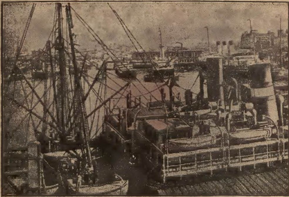
OLBRZYMI POŻAR W PORCIE W BUENOS AIRES (na ilustracji) zniszczył 580 wyładowanych samochodów ciężarowych i spowodował eksplozję wielkich zapasów alkoholu.
