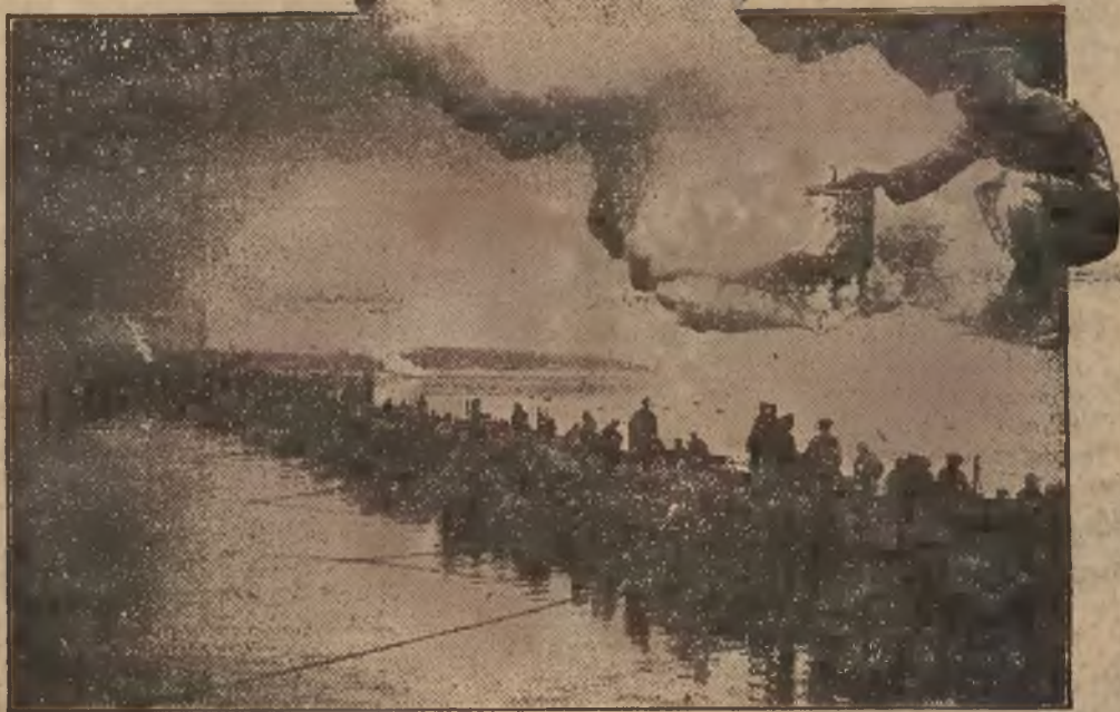
Podczas tegorocznych ćwiczeń Reichswehry trzy bataliony pionierów przeprowadziły budowę mostu na Elbie pod Hohenwarthe (na północ od Magdeburga) pod osłoną sztucznej chmury gazowej. U góry aparat specjalny (Nebeltopf) podczas wytwarzania zasłony gazowej.
