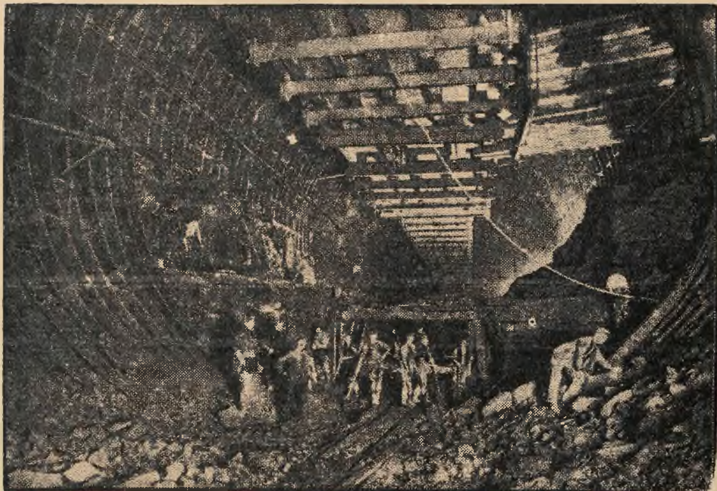
Końcowe prace przy budowie tunelu pod kanałem Mersey, pomiędzy Liverpooliem i Birkenhead w Anglii. Tunel, długości 5 i pół kilometrów ma być wykończony w bieżącym roku i uroczystie otwarty przez króla angielskiego.
