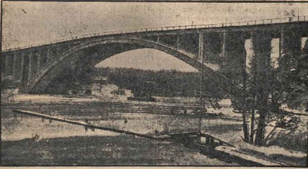
Koło Sztokholmu nad jeziorem Tranebergssund znajduje się na ukończeniu olbrzymi most, którego rozpiętość łuku wynosząca 160 metrów jest największa w całej Europie.
