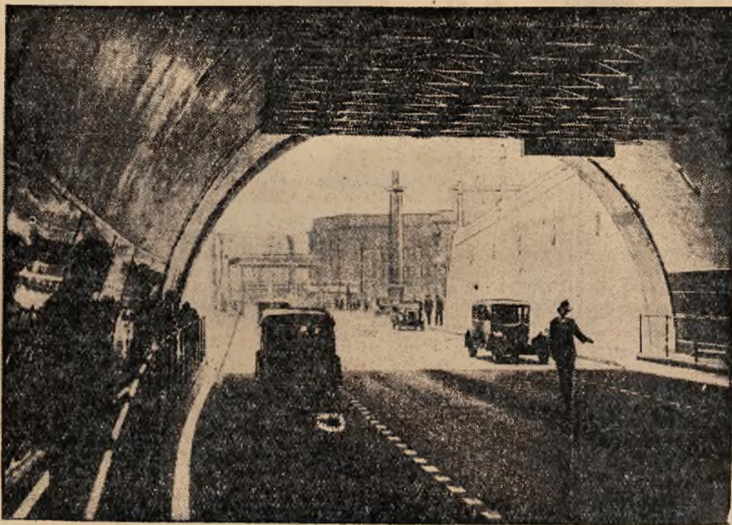
Między angielskimi miastami Liverpool i Birken headem przeprowadzono pod rzeką Mersey tunel, o długości 3 i pół klm. Na zdjęciu widać ujście tunelu w Liverpoolu.
