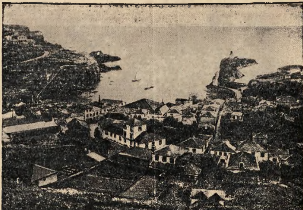
Nad malowniczo położoną wyspą Maderą szalał gwałtowny orkan. Oberwanie chmury spowodowało zalanie ulic, liczne plantacje bananów uległy kompletnemu zniszczeniu.
