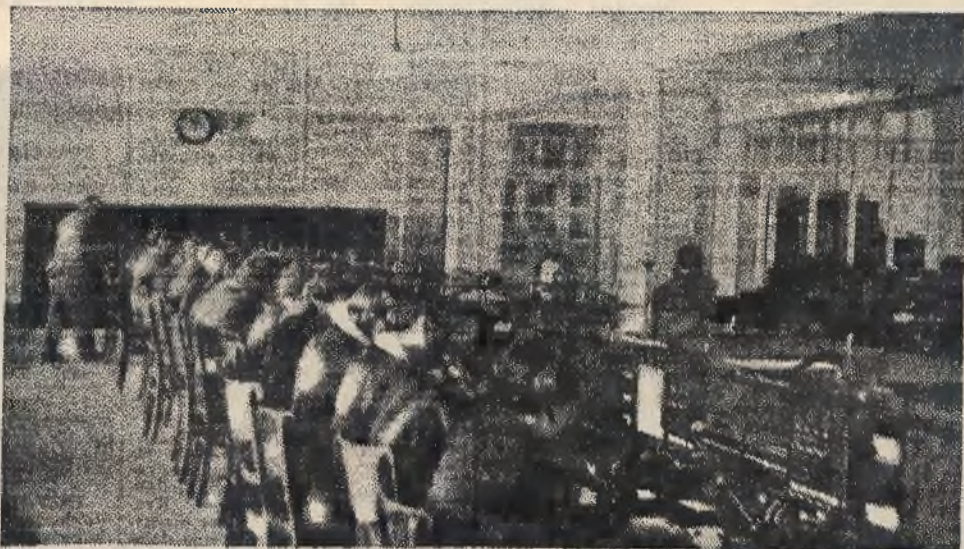
Centrala telefoniczna w Krakowie została już w pełni uruchomiona. Zdjęcie nasze przedstawia fragment centrali krakowskiej z grupą telefonistek łączących abonentów z innymi miejscowościami kraju i zagranicą.
