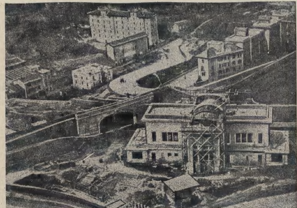
Dworzec kolejowy podczas budowy.
