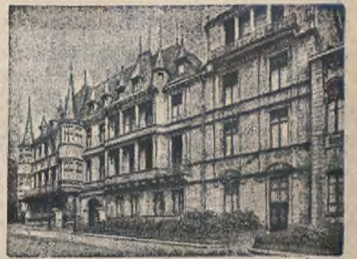
Jeden z rządowych budynków w Luksemburgu.
