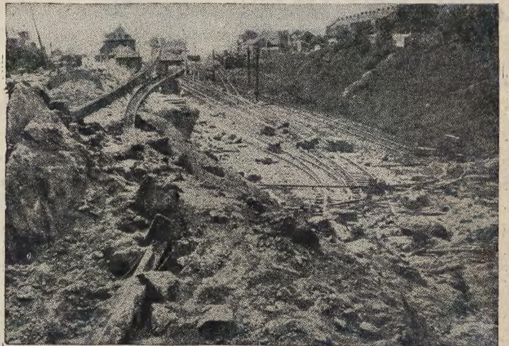
Cofające się wojska francuskie i angielskie wyrzadziły w Belgji olbrzymie szkody. Na zdjęciu naszym widzimy obraz zniszczenia na jednym z dworców belgijskich, który przez wysadzenie w powietrze został zamieniony w stertę gruzów.
