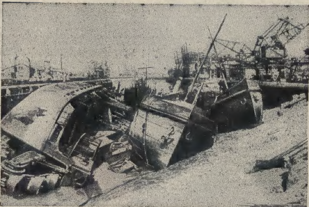
Zdjęcie powyższe przedstawia skuteczność niemieckich nalotów na urządzenia portowe w jednym z miast północno-francuskich. Jeszcze dzisiaj setki zniszczonych okrętów zalegają port. Wszędzie pracują pionierzy i służba techniczna nad usuwaniem zniszczonego materiału.
