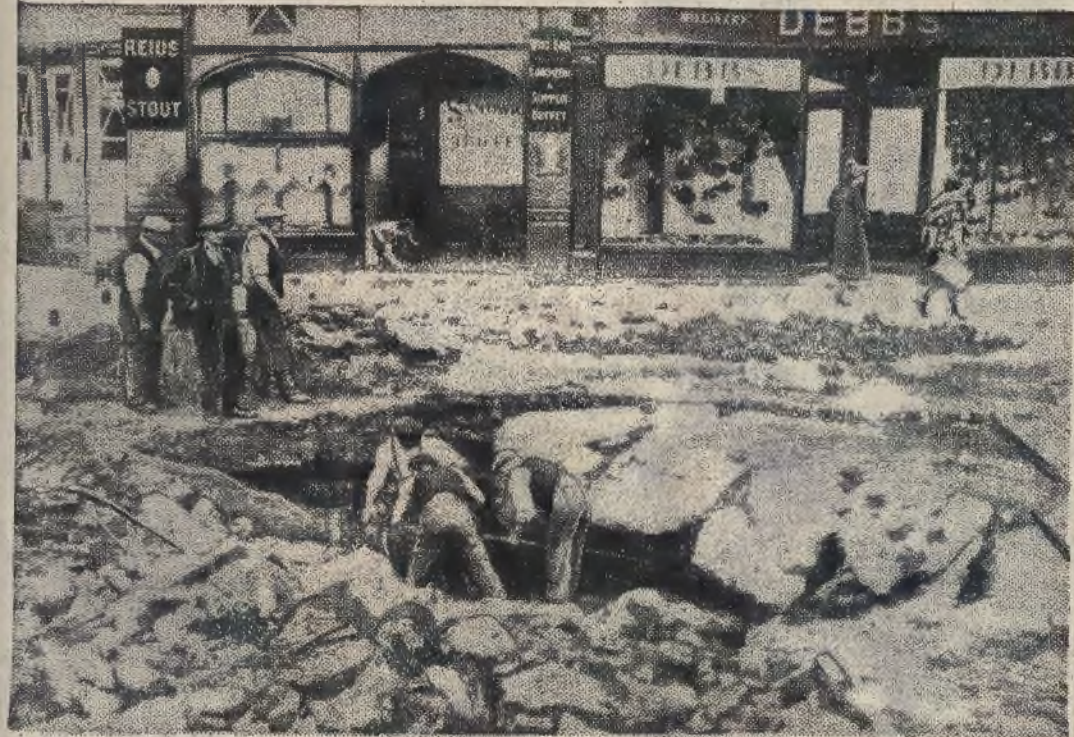
W ostatnich czasach wiele się czytało o niemieckich nalotach na Londyn i inne miasta angielskie. Na zdjęciu naszym widzimy, jak robotnicy pracują nad usunięciem śladów wielkiej wyrwy na pewnej ulicy londyńskiej po jednym z nalotów niemieckich.
