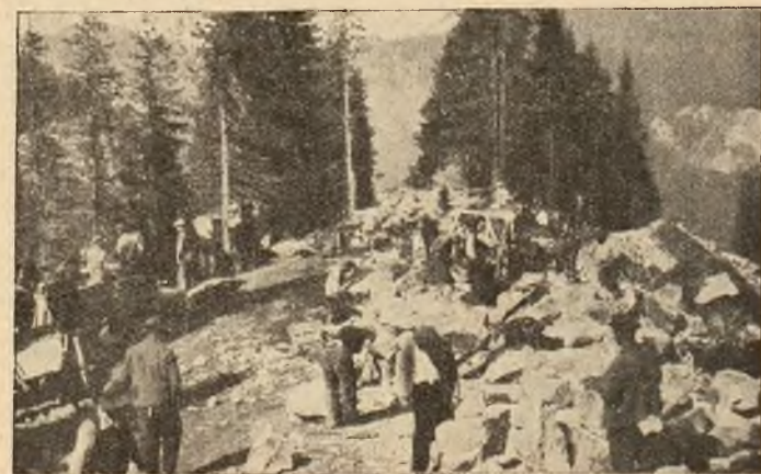
Roboty przedwstępne na trasie kolejki linowej.
