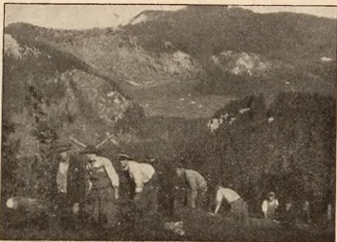
Ciągnięcie stalowej napędnej liny na belę.
