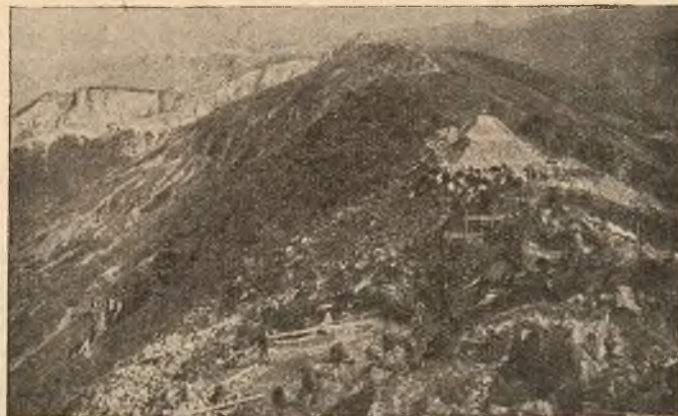
Fundamenta stacji kolejki linowej.
