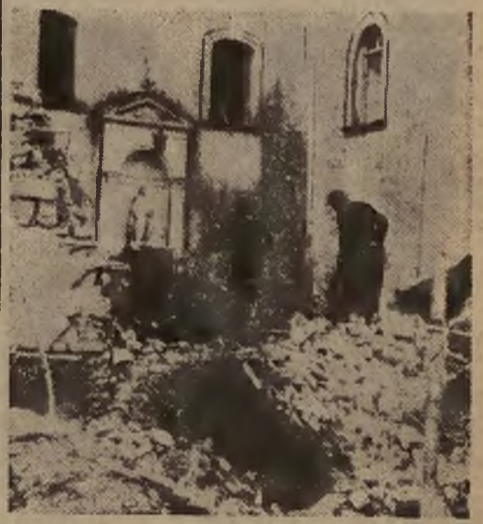
Fragment zniszczenia budynku w Castel Gandolfo.
