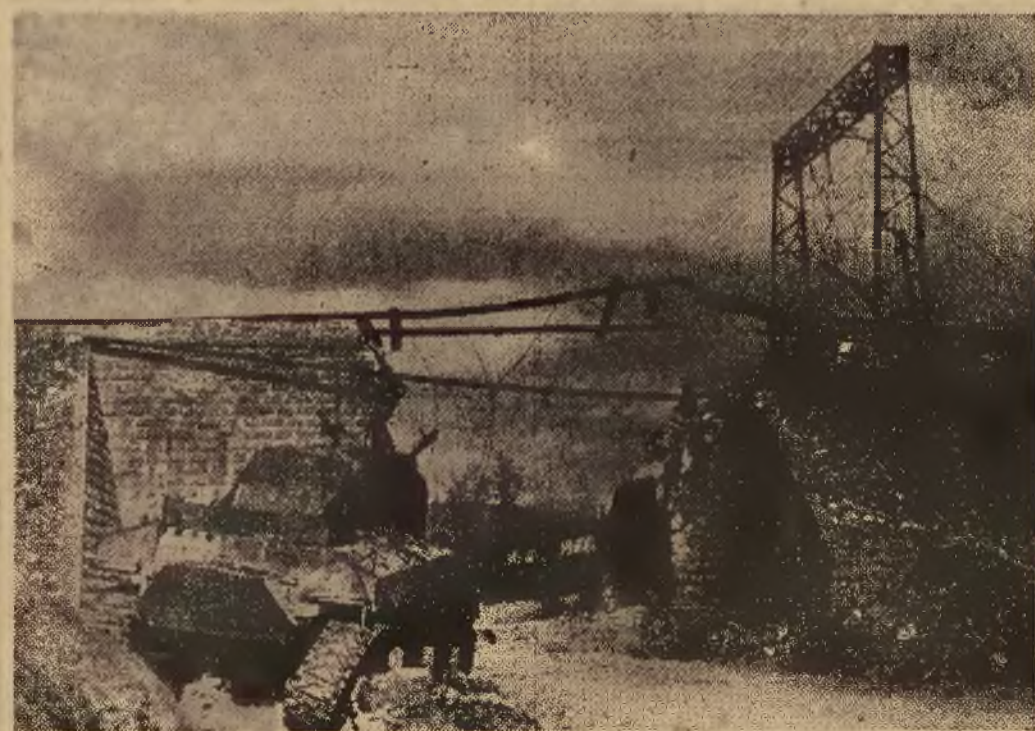
Zniszczony most kolejowy w rejonie działek wojennych, koło Cassino.
